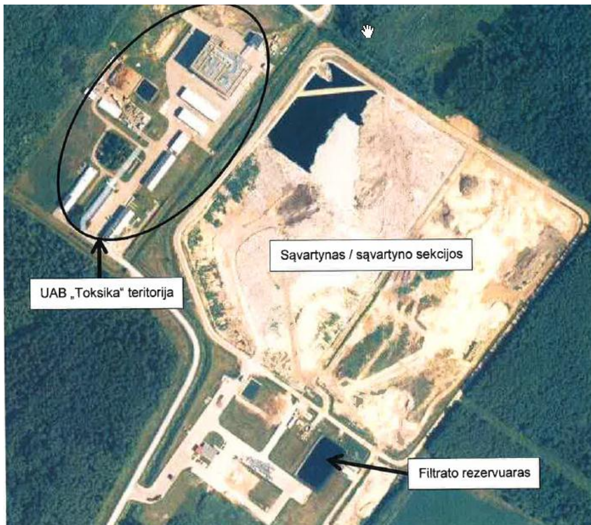
3 pav. Sąvartyno filtrato rezervuaras.
